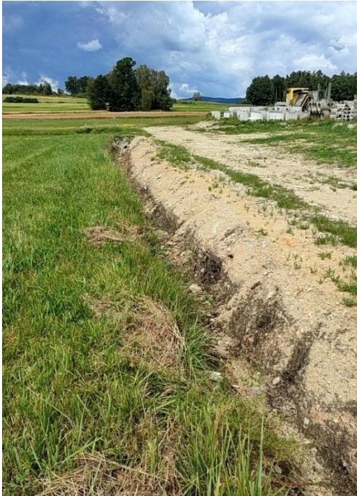
Abbildung 7: Entwässerungsgraben südlich bereits gewidmetes Bauland Blick in Richtung Westen (eigene Aufnahme Juli 2024)
