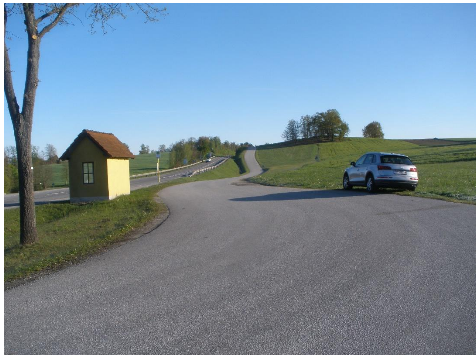
Standort: vor Anschluss Betriebszufahrt Blickrichtung: Norden
