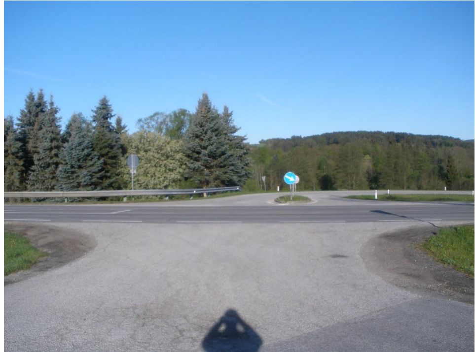
Standort: Anschluss Betriebszufahrt an B41 Blickrichtung: B41
